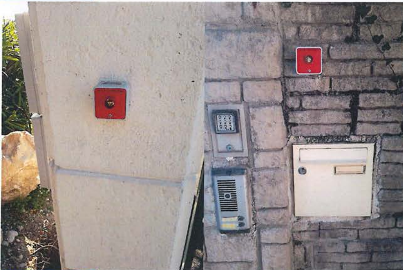
Photos 3 et 4 Installation de systèmes de déverrouillage réservés aux pompiers au niveau des deux portails de la liaison
